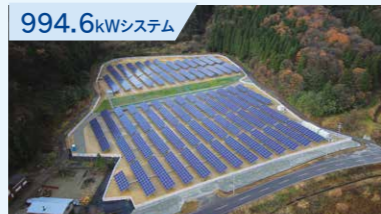
994.6kWシステム 文化シャッター株式会社様 (西山太陽光発電所(新潟県柏崎市))
