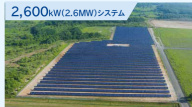
2,600kW(2.6MW)システム シャープ苫小牧第一太陽光発電所 (北海道苫小牧市宇柏原)
