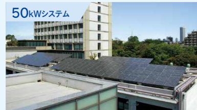
50kWシステム 国立大学法人 東京大学様 (東京都文京区)
