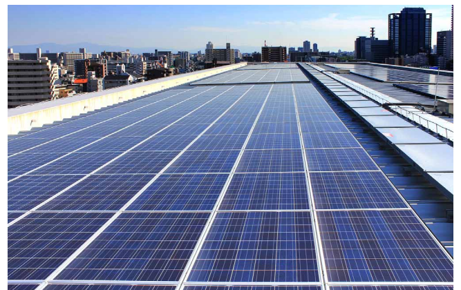
8階建て新校舎の金属製折板屋根のほぼ全面に敷設
