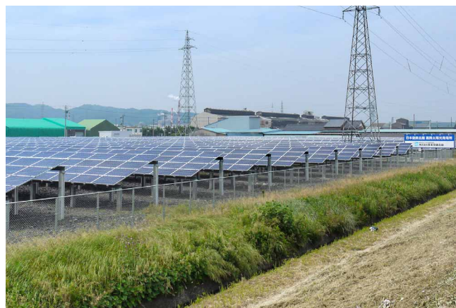
庄川左岸の約2.4haに設置された7,420枚の太陽光パネル
