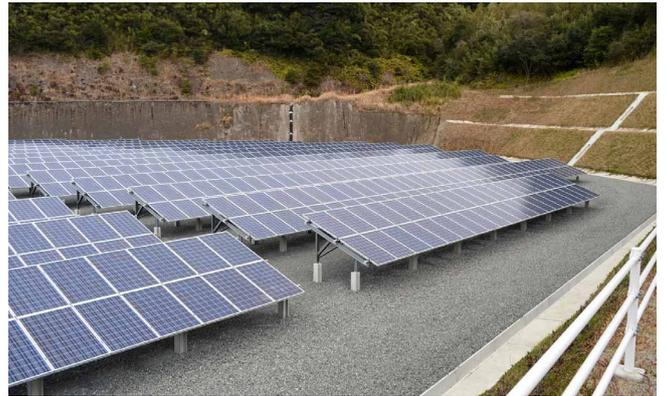
約2.3ヘクタールの敷地に4,172枚の太陽電池モジュールを設置
