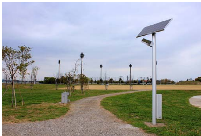
公園周辺は掘るとすぐ水が湧く地盤だが、筒型の銅管を地中に埋め込むポールアンカーシンクレス工法対応のため、低コストで設置できたことも選ばれた理由
