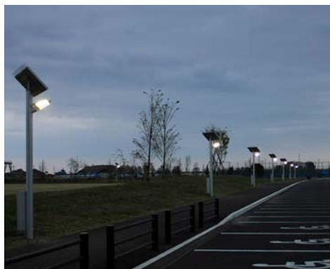
多目的広場を囲む歩道を中心に計12基を設置 （施工：株式会社不二電工さま・鴻巣市）
