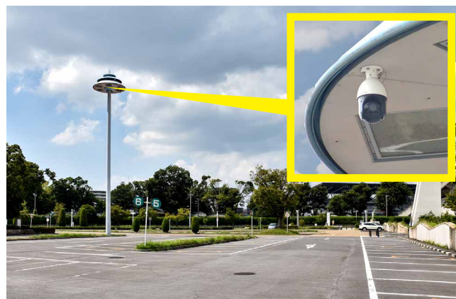
駐車場の高さ約20mの照明ポール上部にも設置
