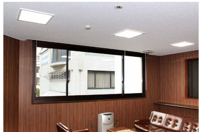
応接室には埋込スクエア型と業務用加湿空気清浄機を設置
