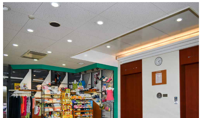
スポーツジムのフロアでは、ベースダウンライトに加えてエレベーター上部にライン照明を設置し演出されています
