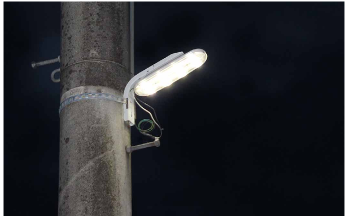
光を上空に拡散させないカバー一体型の構造
