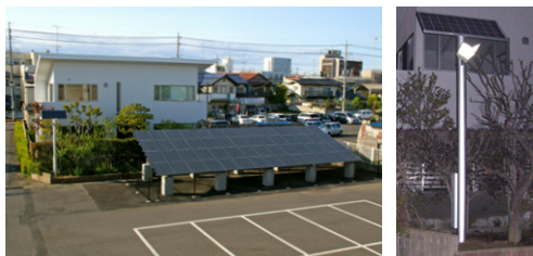
駐車場には太陽光発電パネルとソーラー・LED照明灯
