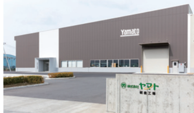
朝倉工場・サポートセンター
